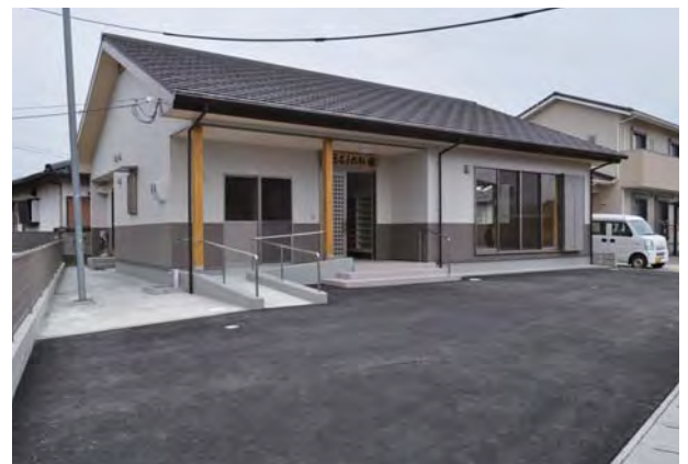
自治公民館施設整備
