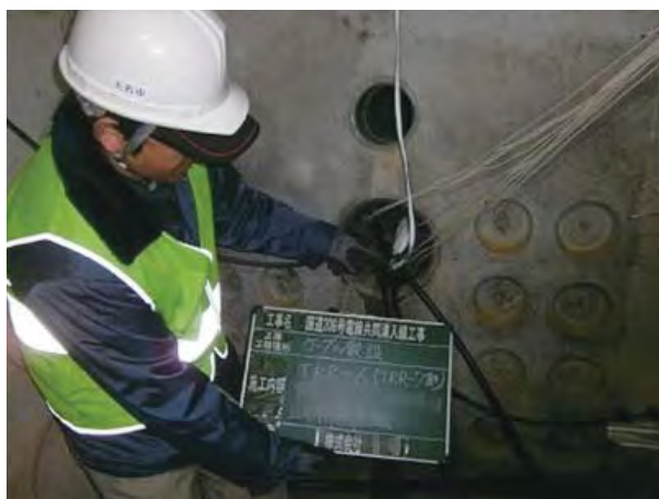
国道208号電線共同溝内地下管路入線作業の様子
