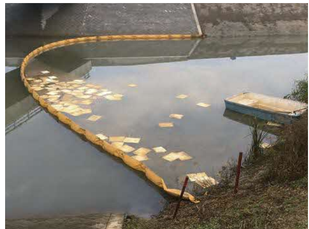
油漏れ防止ネット
