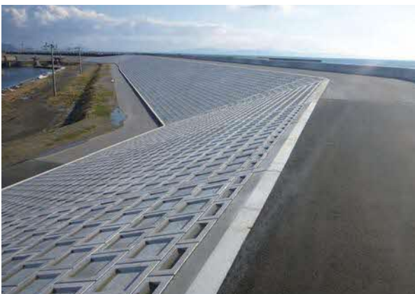
海岸保全施設(左：堤防、右：排水樋門)
