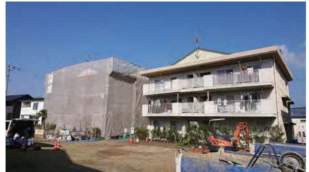
公営住宅の外壁改修
