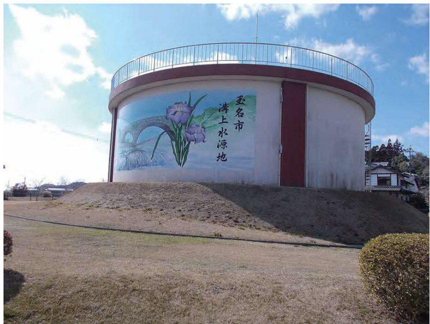
取水施設(溝上水源)
