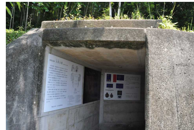
大坊古墳保護施設入口
