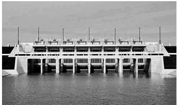
▲横島干拓2号排水樋門
