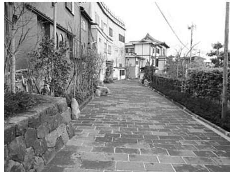
高津原立願寺線 (温泉石畳整備)
