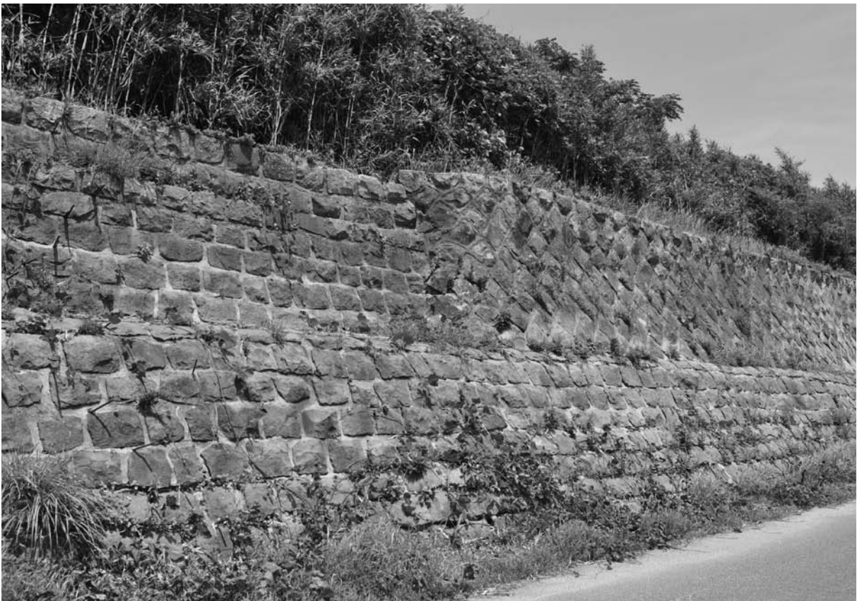
写真 31 末広開潮受堤防上半部の積み方が異なる部分
