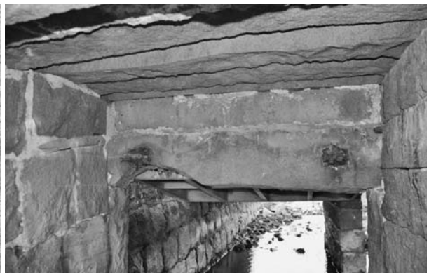
写真 48 末広開二枚戸樋門通水路招戸設置部分裏側（西から）
