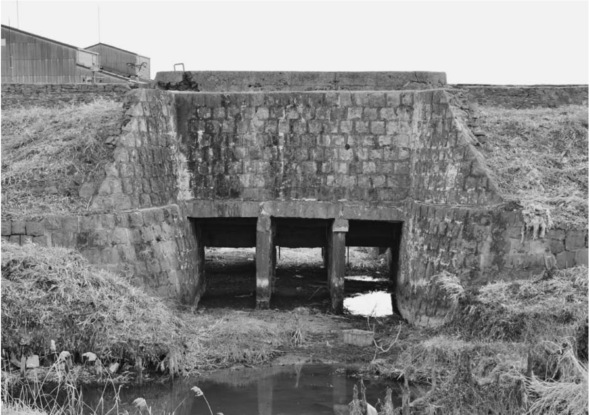
写真 40 末広開東三枚戸樋門（北から）
