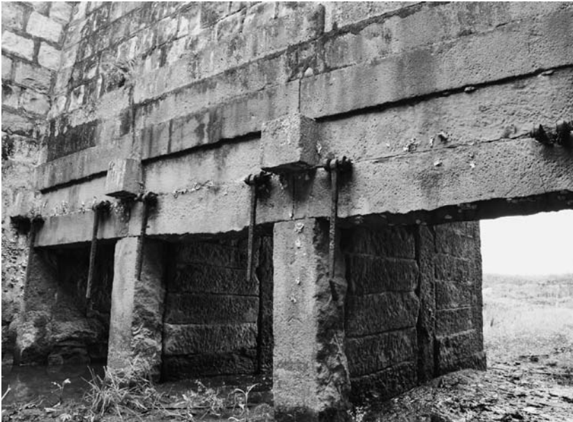
写真 38 未広開東三枚戸樋門招戸設置部分
