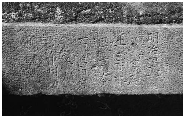
写真 51 末広開二枚戸樋門招戸設置面上部の碑文
