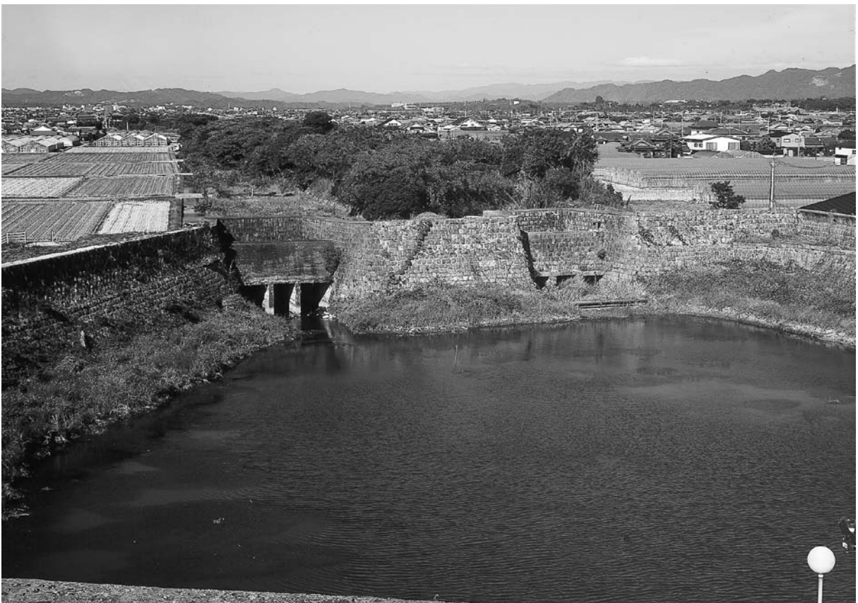
写真 33 末広開樋門の土砂除去後（南から）
