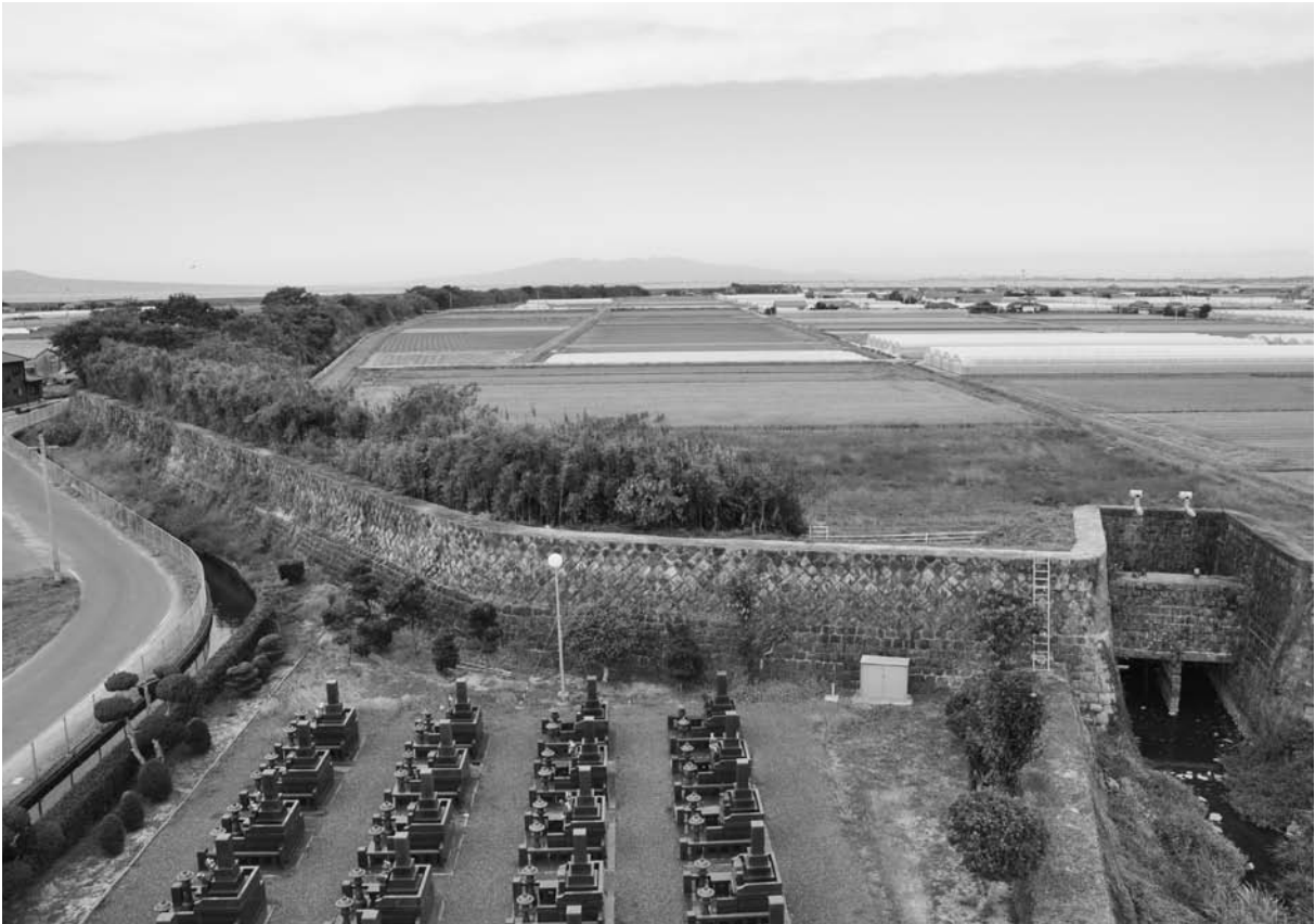
写真 30 末広開潮受堤防（東から）
