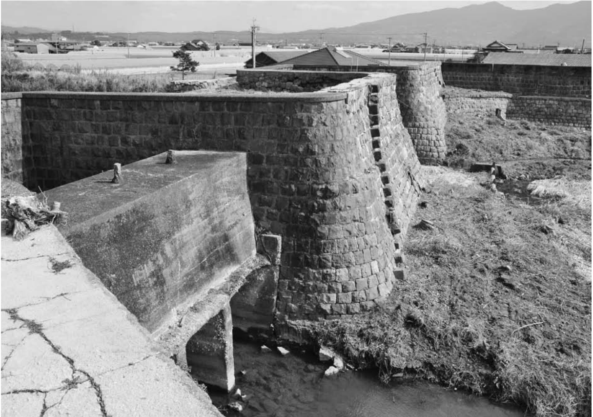
写真 34 手前：末広開西三枚戸樋門 奥：末広開東三枚戸樋門（西から）
