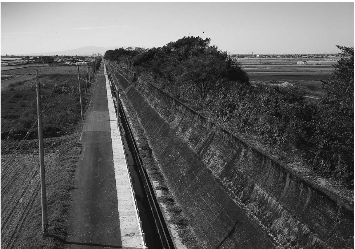
写真 55 大豊開潮受堤防（東から）
