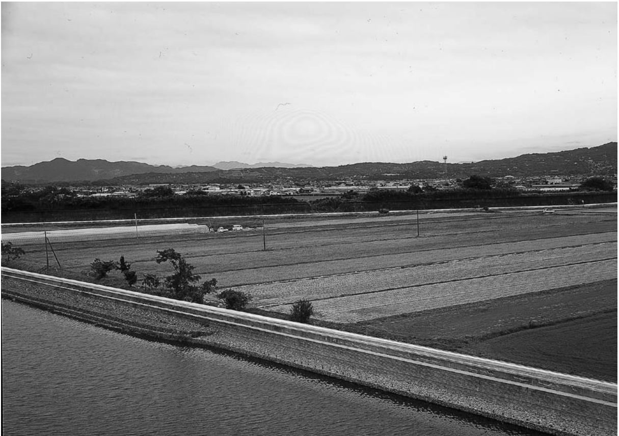
写真 54 明豊開潮受堤防（南西から）
