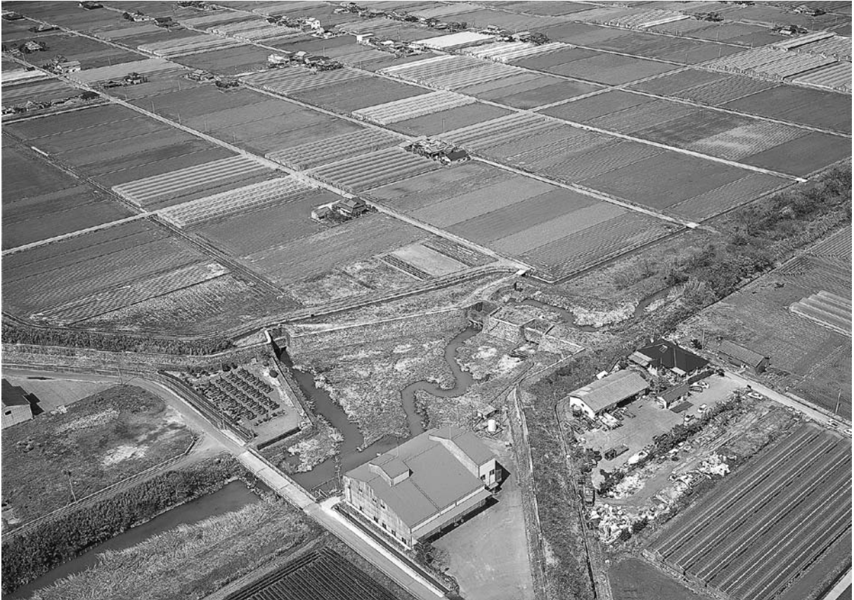
写真 32 末広開樋門の土砂除去前（南東から）
