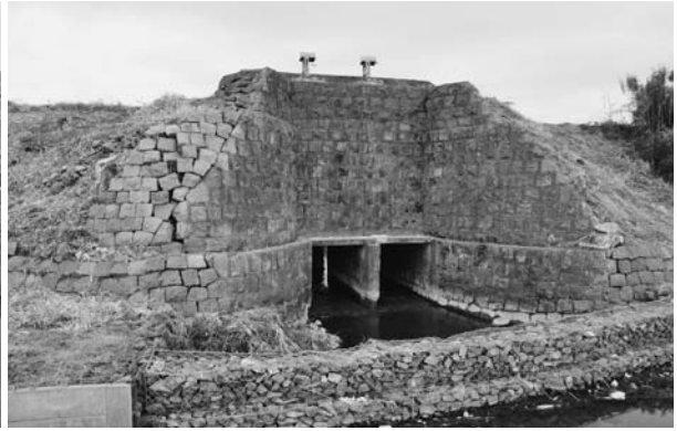
写真 46 末広開二枚戸樋門干拓地側（西から）
