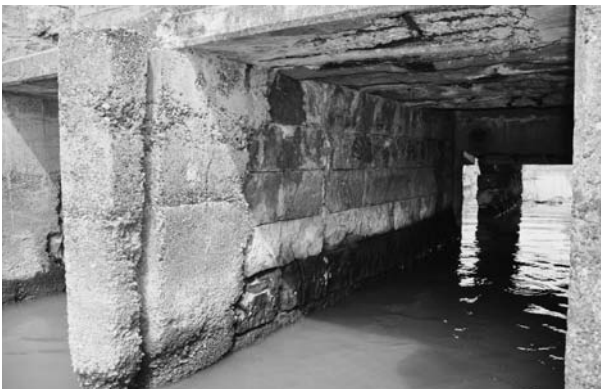
写真 47 末広開二枚戸樋門通水路（西から）
