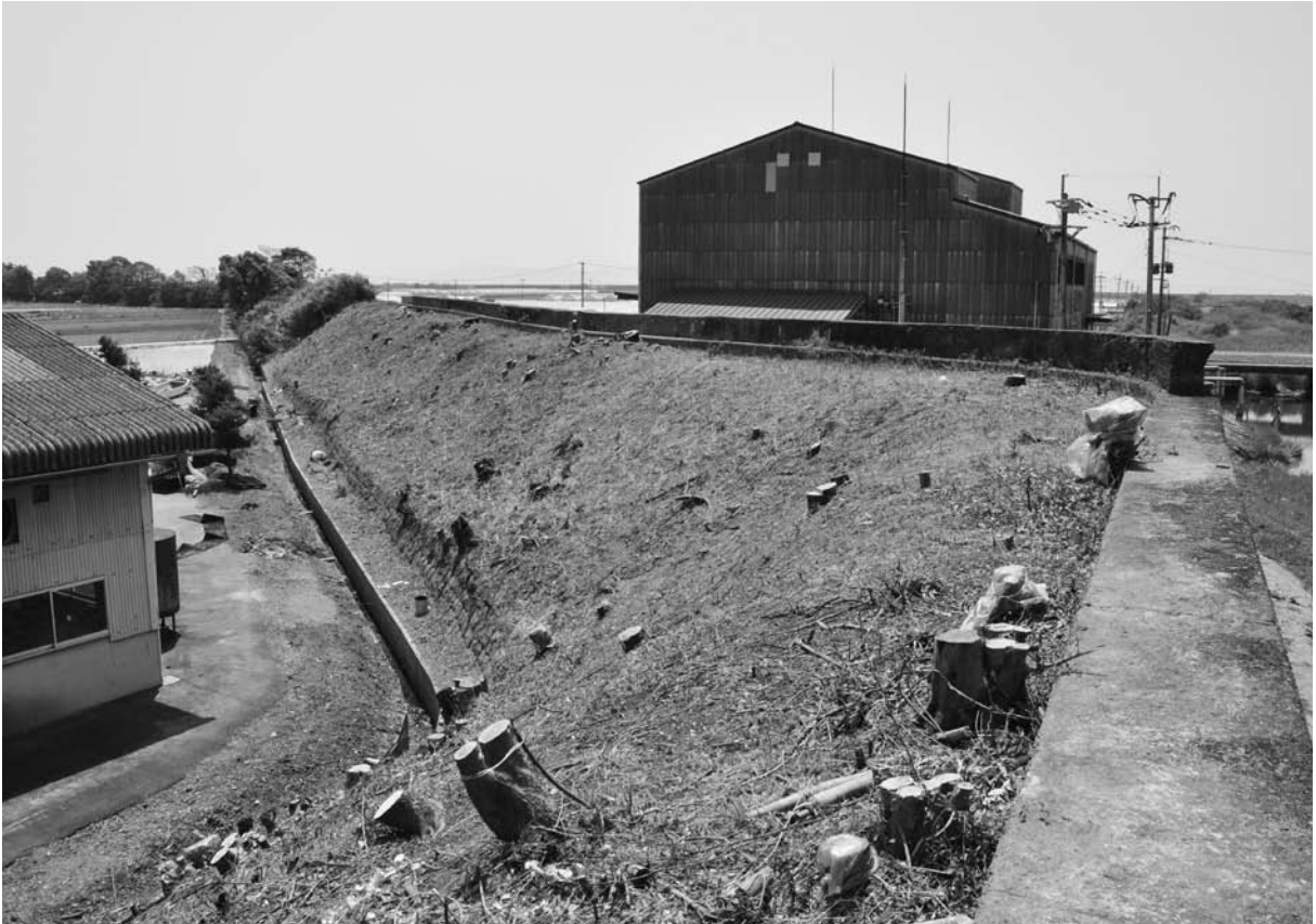
写真 52 明丑開潮受堤防干拓地側法面（北西から）
