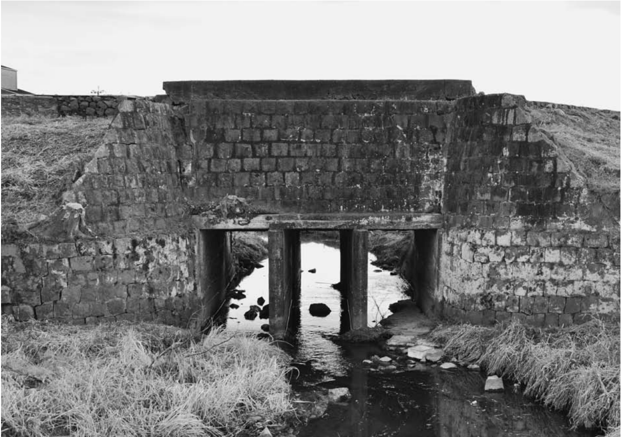
写真 42 末広開西三枚戸樋門（北から）
