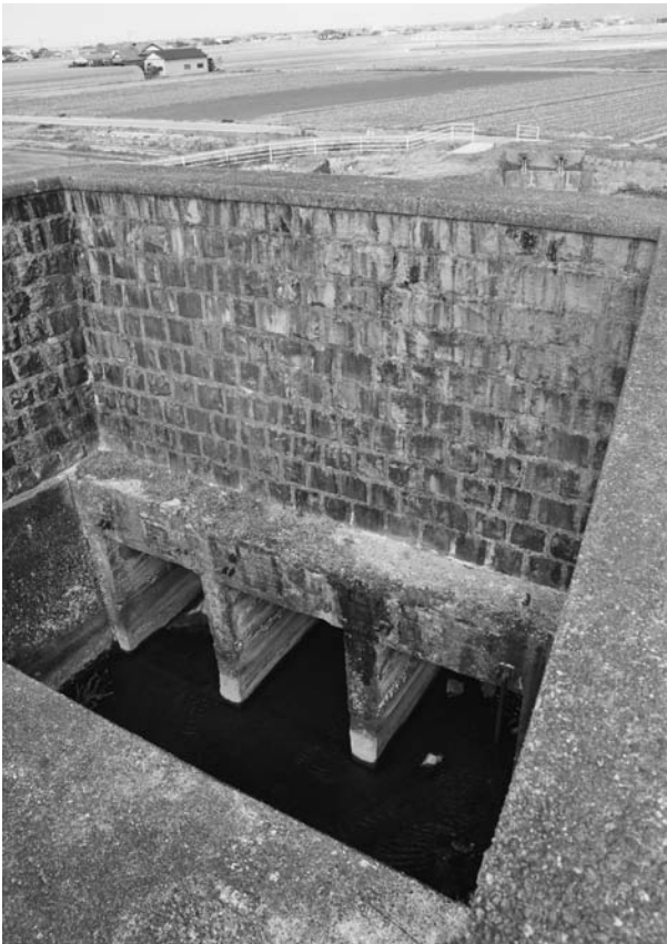
写真 35 末広開西三枚戸樋門の招戸設置面
