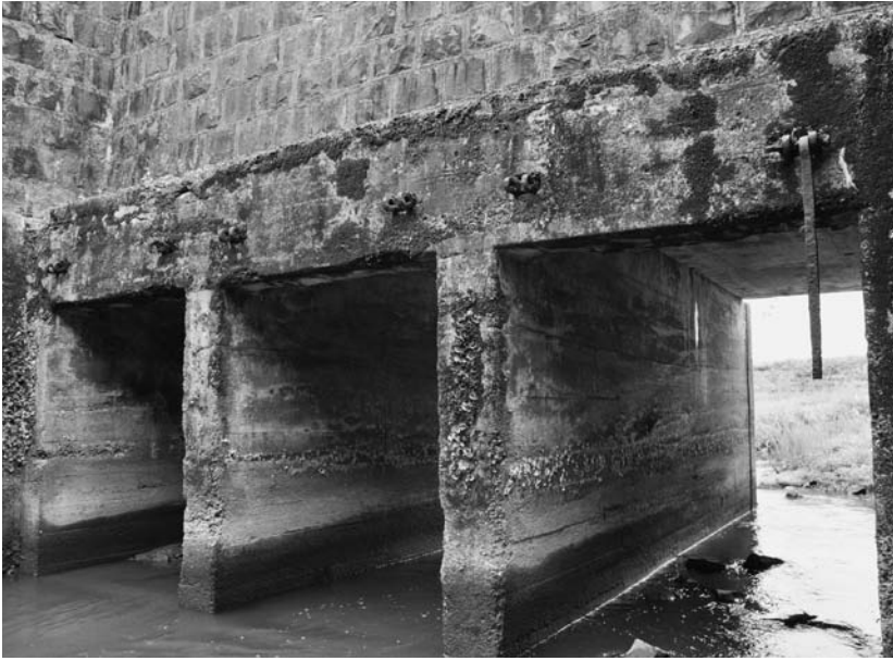
写真 37 未広開西三枚戸樋門招戸設置部分
