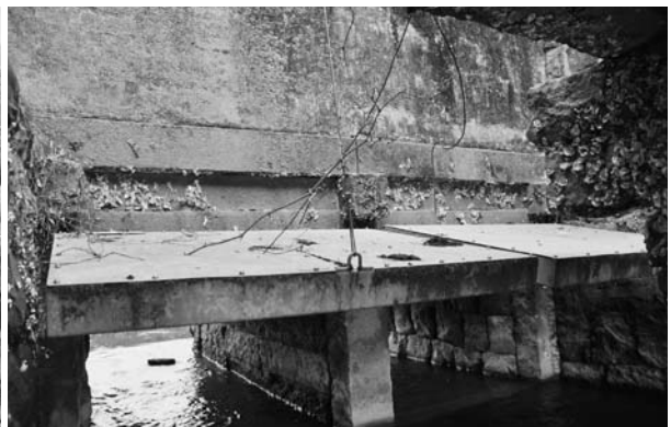
写真 50 末広開二枚戸樋門の招戸設置面（東から）
