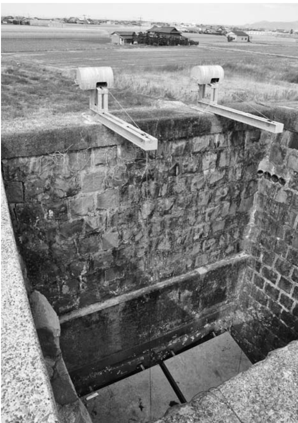
写真 49 末広開二枚戸樋門の招戸設置面（東から）
