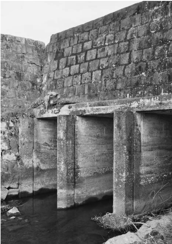
写真 43 末広開西三枚戸樋門通水路（北から）
