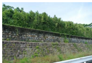
干拓施設(堤防)
