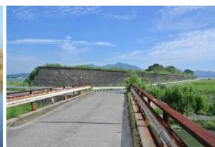
干拓施設（堤防）
