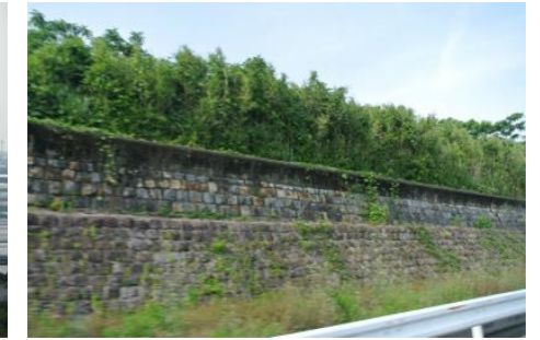
干拓施設(堤防)
