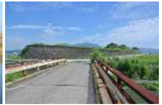
干拓施設(堤防)
