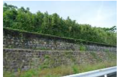
干拓施設(堤防)
