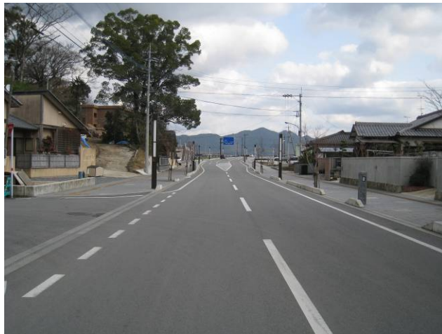
立願寺横町線（一部完成）
