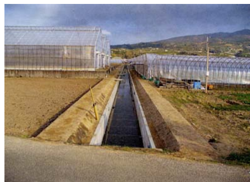
整備中の用水路
