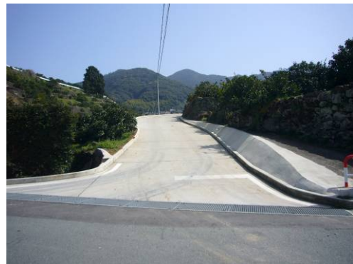
道路の拡幅工事完了後
