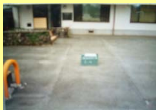
敷地内通路 着工前
