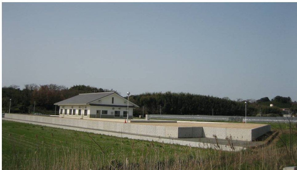
天水町尾田河左岸地区汚水処理場
