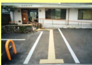
敷地内通路 しゅん工
