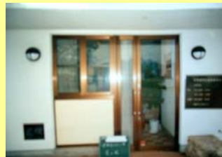
建物出入口 着工前
