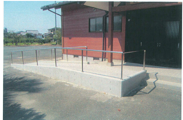
公民館玄関前スロープ新設
