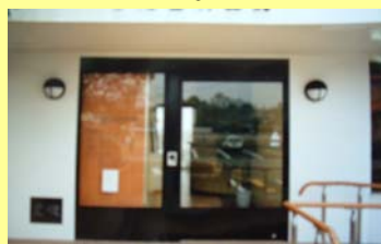
建物出入口 しゅん工
