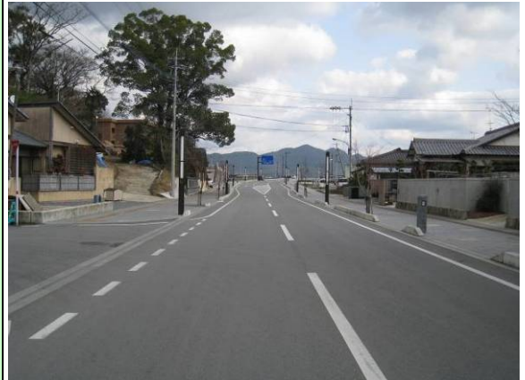
立願寺横町線（一部完成）
