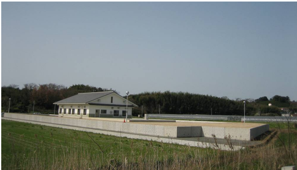
天水町尾田河左岸地区污水处理場
