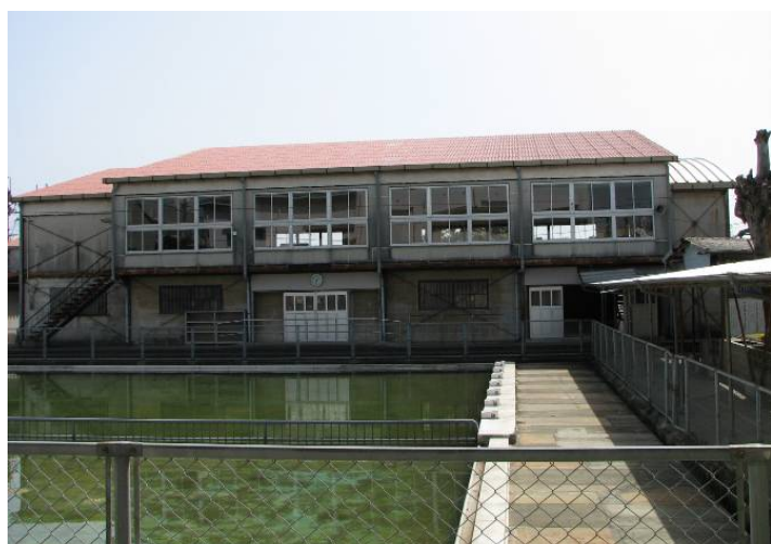
建替え予定の玉名町小学校体育館・プール
