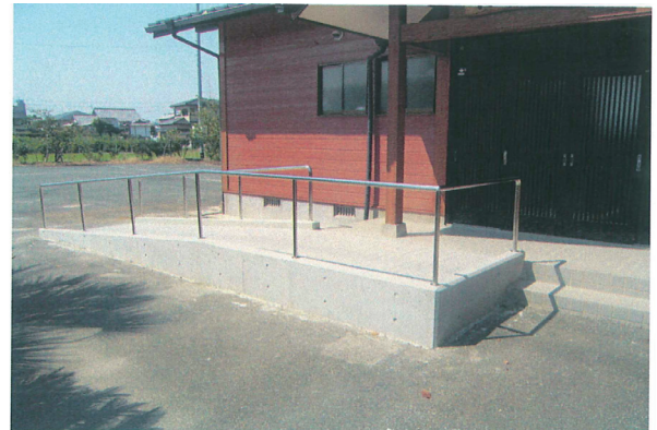
公民館玄関前スロープ新設
