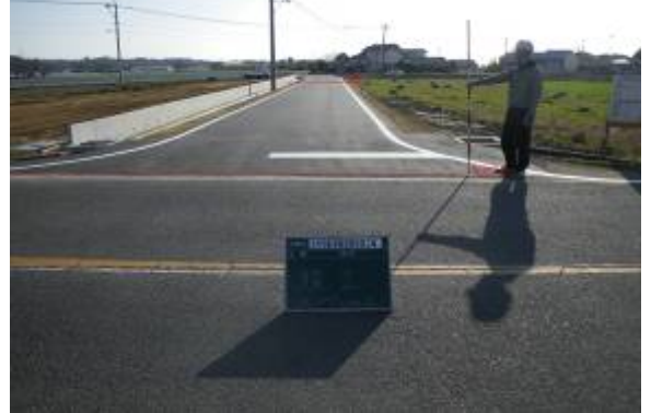
○拡幅後舗装を新しくした市道です。
