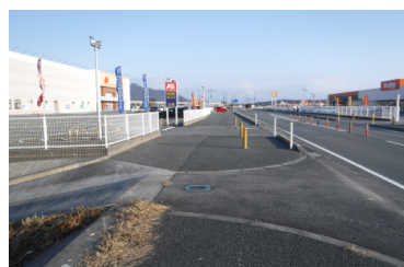
下水道整備予定地
