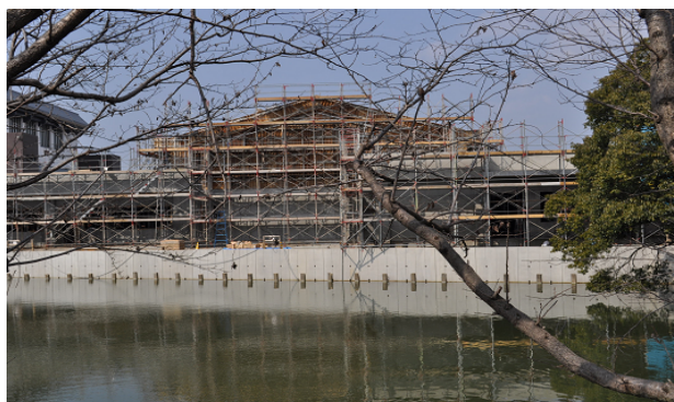
建設中の玉名市天水市民センター
