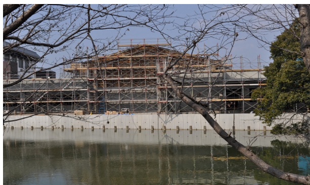
建設中の玉名市天水市民センター
