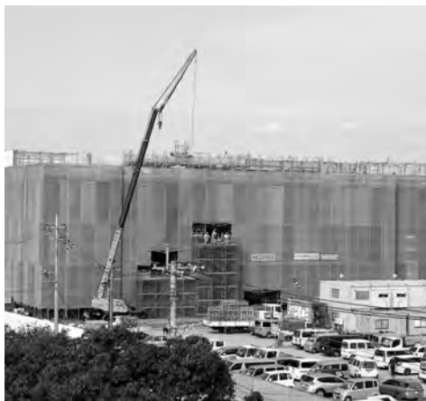
▲完成間近の新庁舎(H26.9.17現在)
