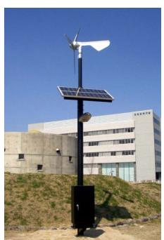
である新エネルギー・産業技術総合開発機構の補助を受け、地球温暖化対策として設置したもの。電力には太陽光と風車による風の力を利用し、照明には、国家プロジェクトとして開発された消費電力が蛍光灯の1/2で寿命は半永久的な白色発光ダイオード(白色LED)を使用しています。
