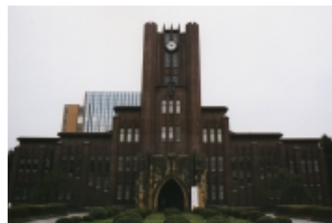
▲学生なら一度は憧れる安田講堂。奥のガラス張りは最近建設された医学部校舎
