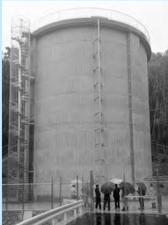
▲九州新幹線渇水対策施設 石貫4区1号配水池(PCタンク)
