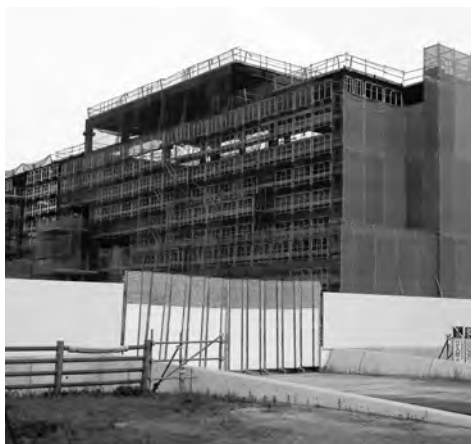
▲現在建設中の新庁舎
