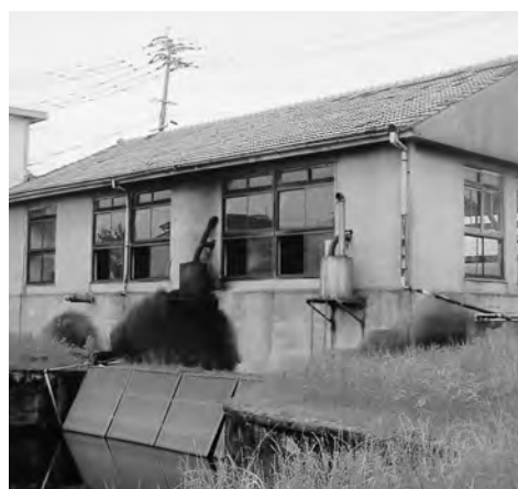
▲改修が必要な岩崎排水機場
