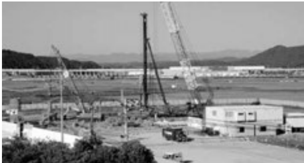
▲現在のくい打ち工事の様子
