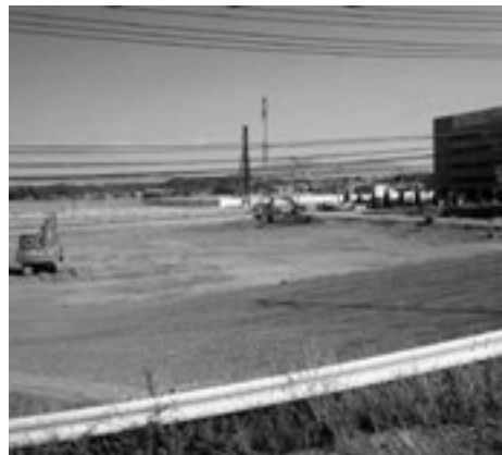
▲整備中の新庁舎職員駐車場
