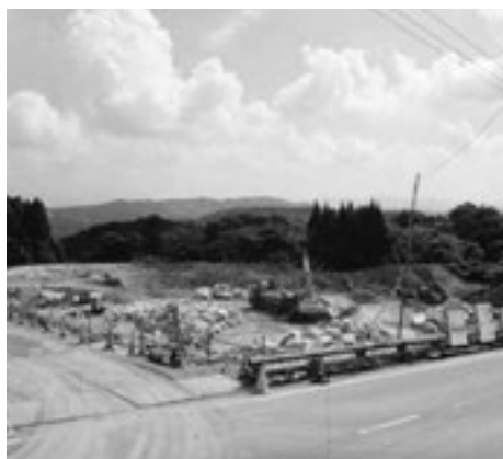
▲新幹線渇水対策施設建設現場
