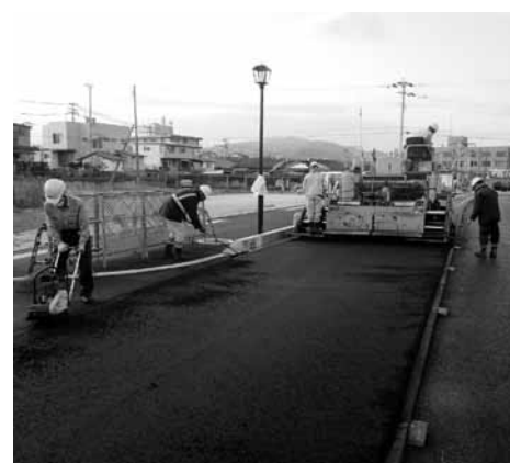
▲舗装工事状況
