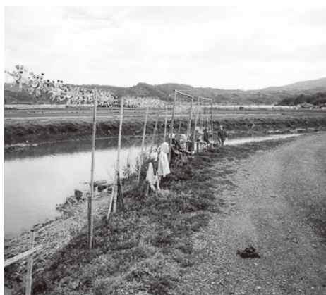
▲改修を急がれる尾田川
