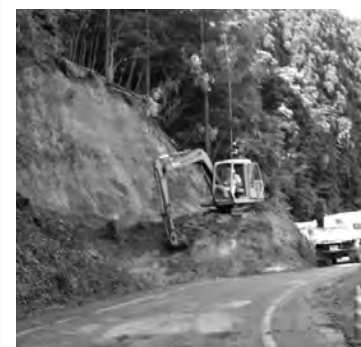
▲ユンボによる崩れた土砂の撤去作業
