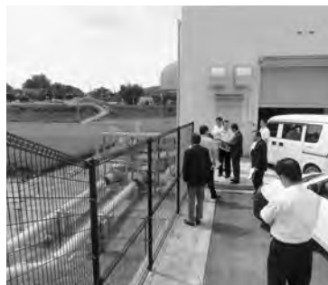
▲今回請願された田崎地区(赤川ポンプ場)現地視察
