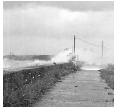
▲長保堤防に打ち寄せる荒波
