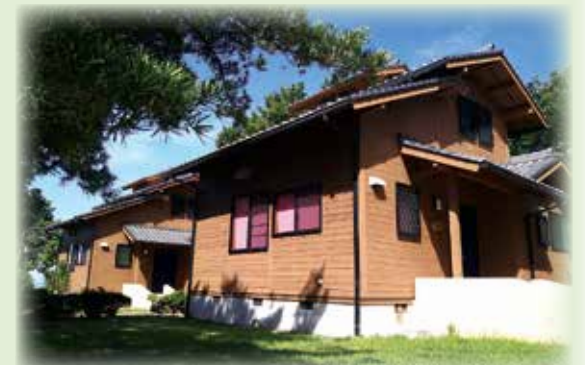
▲ロッジ4棟が立ち並ぶ草枕山荘キャンプ場
