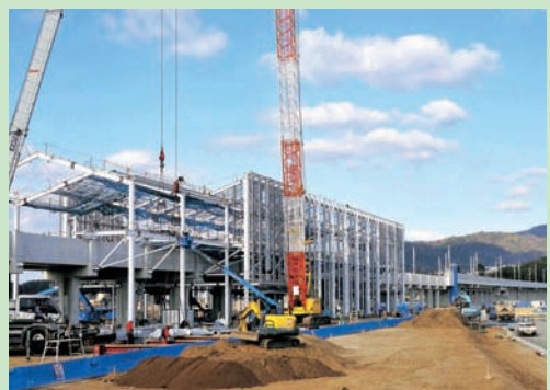
▲工事中の新玉名駅
