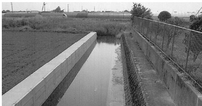
▲ 明辰川改修工事
