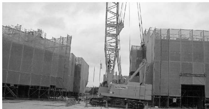
▲ 天水中学校建設現場
