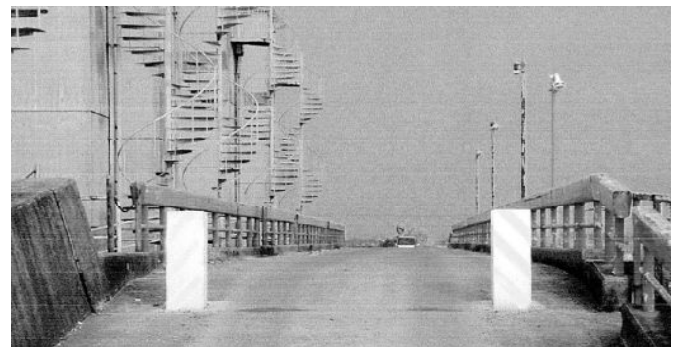
▲ 防潮樋門管理道路
