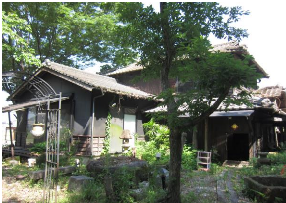
【外観】 令和4年5月 撮影
