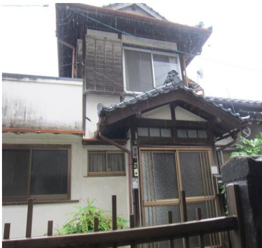
【外観】 令和4年5月 撮影
