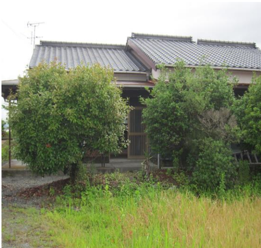
【外観】 令和4年6月 撮影
