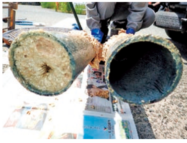
▲正常な排水管④と異物が詰まった排水管⑤
