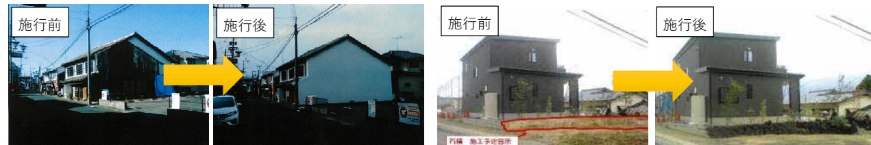
【実績例】隣家の解体で露出した外壁の修景（高瀬・裏川地区）
