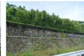
干拓施設(堤防)
