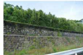
干拓施設(堤防)
