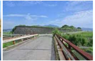
干拓施設(堤防)
