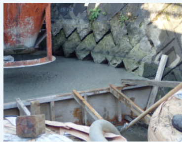
施工時の状況
