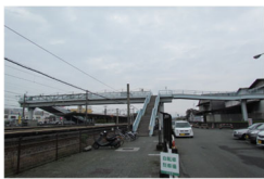
歩道橋(人道橋)
