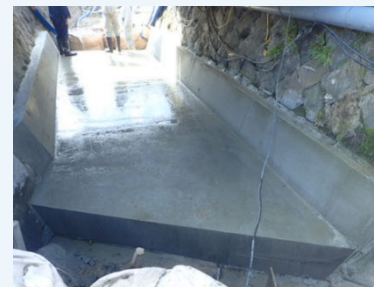
施工後の状況
