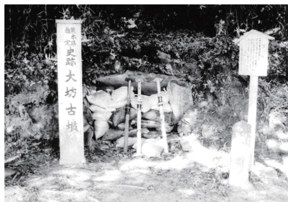
整備前の大坊古墳石室入口
