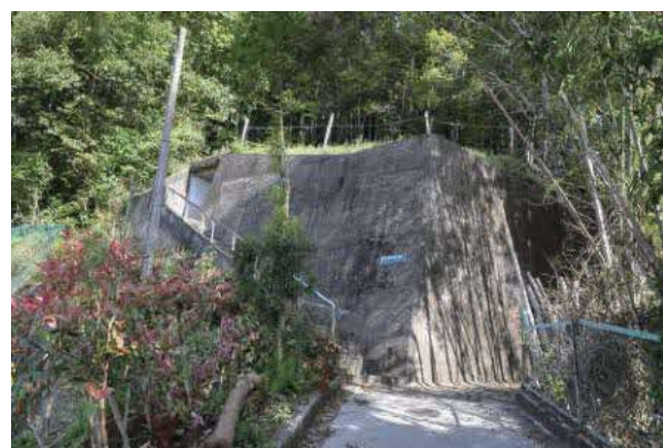
大坊古墳保護施設（南から）
