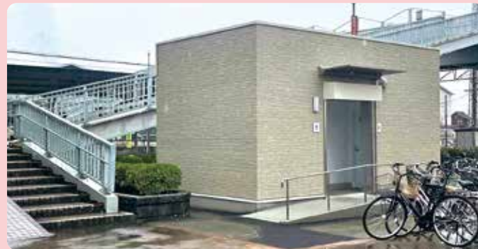
玉名駅西側に設置された屋外トイレ
