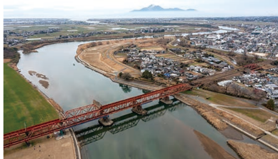
▲高瀬大橋上空から河口方向を望む
