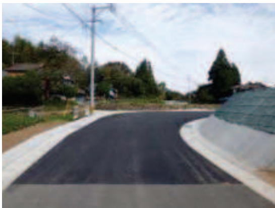
写真 生活道路の改良工事
