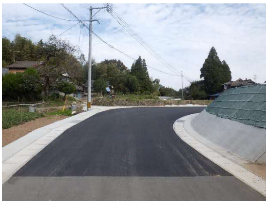
写真 生活道路の改良工事
