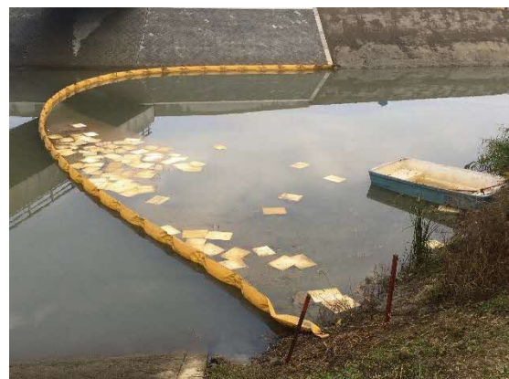
写真 油漏れ防止ネット
