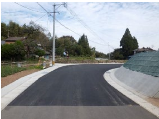
写真 生活道路の改良工事
