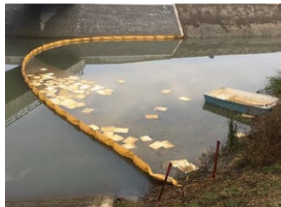
写真 油漏れ防止ネット
