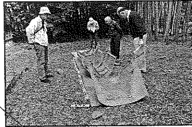
□風防内部状況と調査状況 左：機首側より 残存長4.10mを計る。 右：尾翼側より機首側を見る。内部仕切り状況が判明
