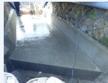
施工後の状況
