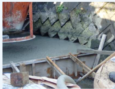
施工時の状況
