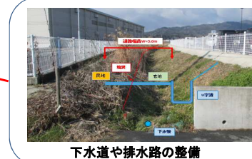
下水道や排水路の整備
