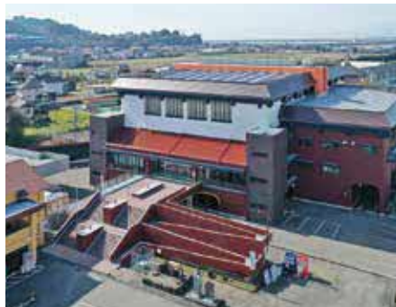
▲過疎債を活用して中規模改修を行った天水体育館
