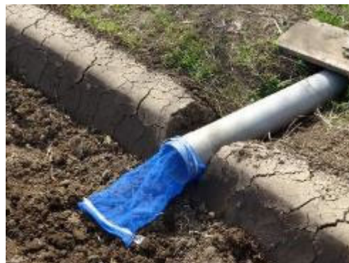
取水口への網の設置
